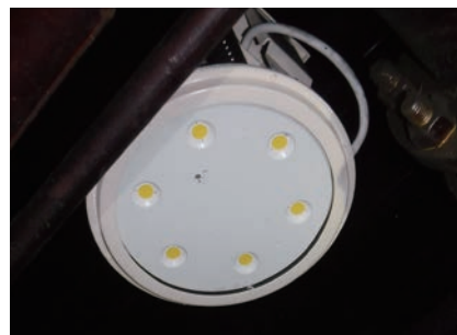
某製鉄所内（電源が置けない場所）
