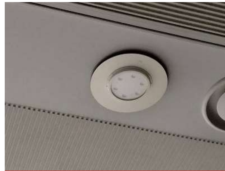
③ 【LED照明が固定される】
