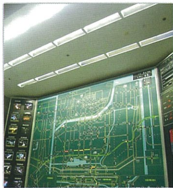
新潟県庁交通管制センター様 2009年1月施工
