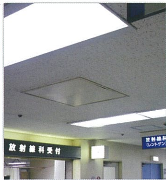
平塚市民病院様 2012年3月施工
